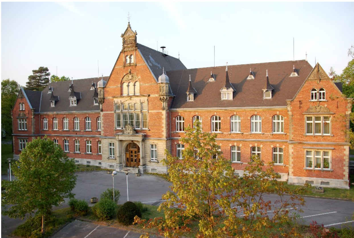
LVR-Klinik Langenfeld (Haus 62, Verwaltungsgebäude)
